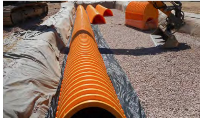
Lebensmittelmarkt in Rheinland-Pfalz. BIRCO Rigolentunnel von StormTech® bestehen aus gewölbeförmigen Versickerungskörpern. Sie sind stapelbar, dadurch benötigen sie bei der Lagerung und beim Transport rund zwei Drittel weniger Platz als andere Lösungen. Foto: Müller + Huber
