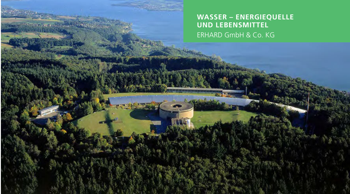
Wasserwerk Sipplinger-Berg, Zweckverband Bodensee-Wasserversorgung
