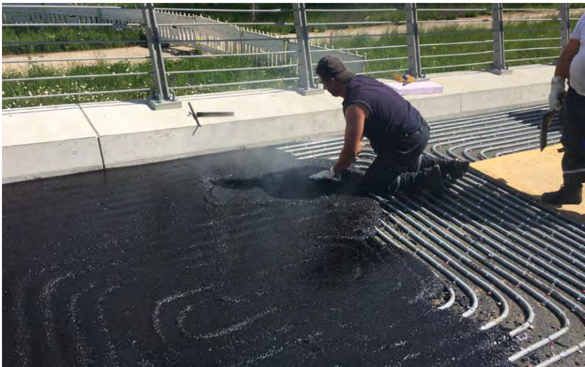
Bild 4: Aufbringen der Schutzschicht aus Gussasphalt zur Ummantelung der Heizschleifen.
