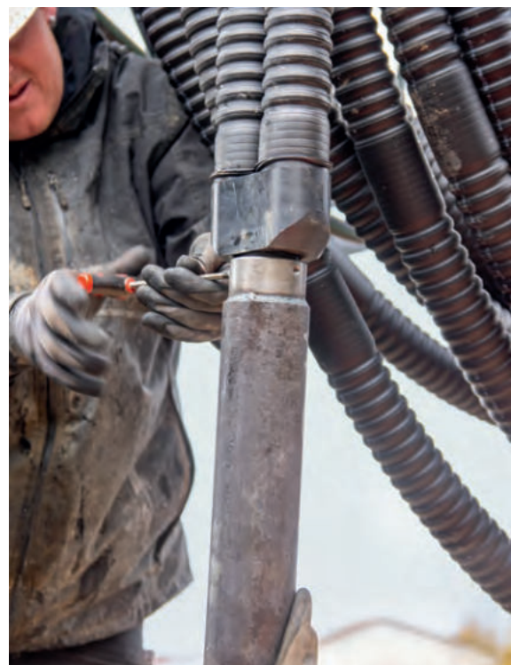
Schnell montierbare und gut gesicherte Sonden-gewichte
