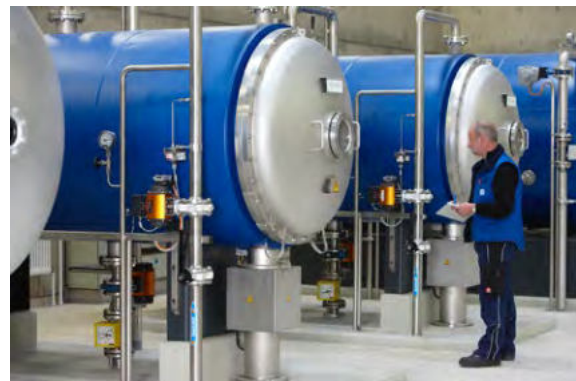
Umwandlung von Sauerstoff in Ozon in sog. Röhrenozoneure
