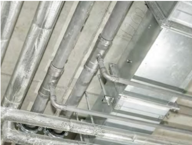
Mit den „Megapress“-Verbindern konnten bereits vorlackierte Stahlrohre installiert werden. Der wirtschaftliche Vorteil: Es war kein zeitintensiver Korrosionsschutzanstrich mehr für die Stahlrohre auf der Baustelle notwendig.
