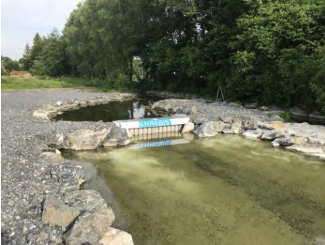
Hinter dem ENREGIS/Vivo® TRP im Auslauf wird das Wasser wieder in den Pulverriedgraben eingeleitet.
