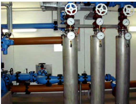
Die alten Rohrmantelpumpen im GPW Wolkertsham und DPW Opping werden ausgebaut.
