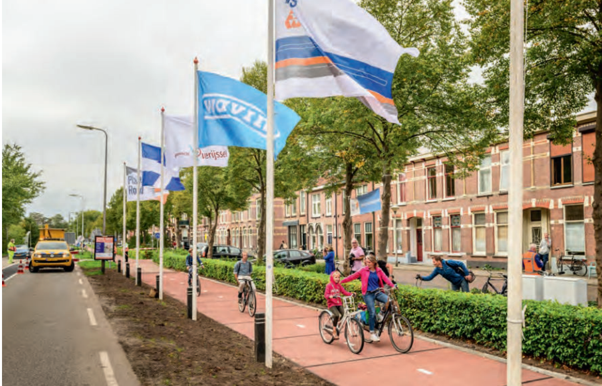
Die ersten beiden Pilotprojekte rund um die Straße aus Kunststoff werden in Form von 30 Meter langen Radwegen in den Niederlanden realisiert.
