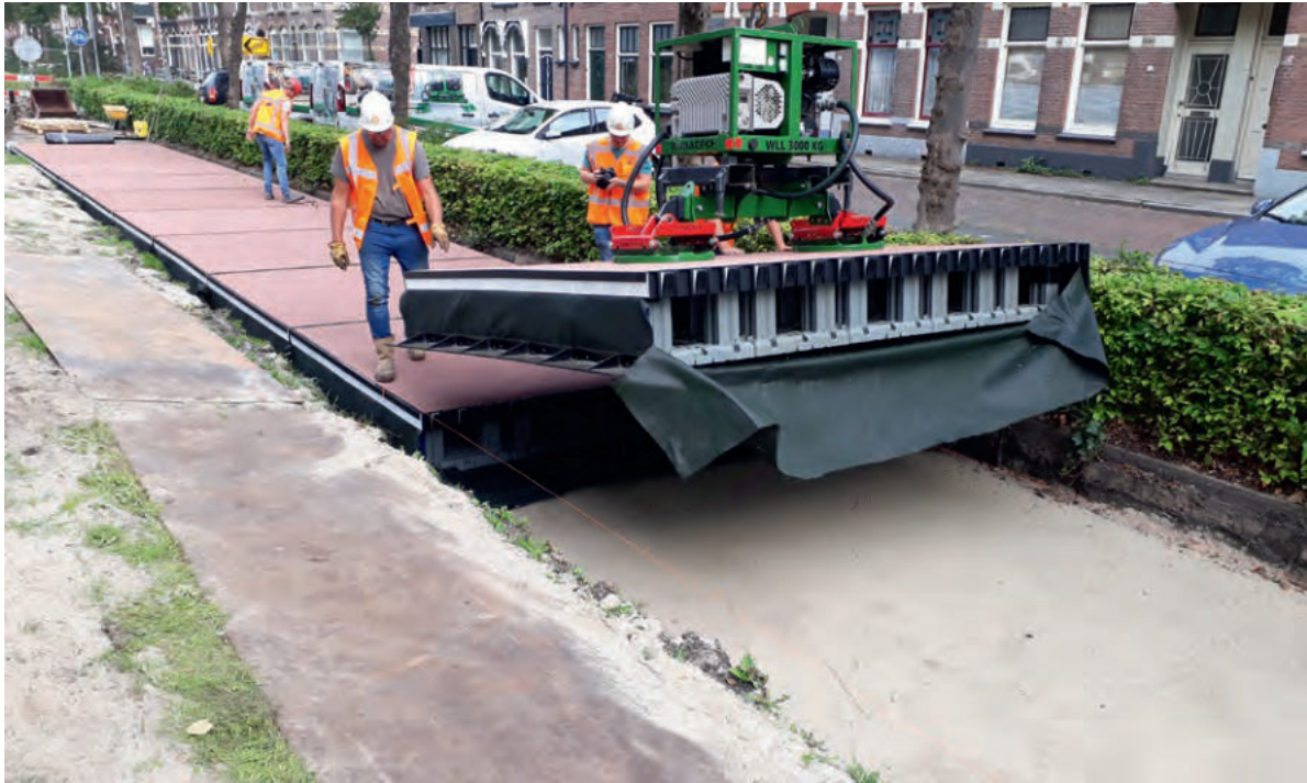
Die Straße aus Kunststoff überzeugt durch ihr leichtes Handling vor Ort auf der Baustelle.
