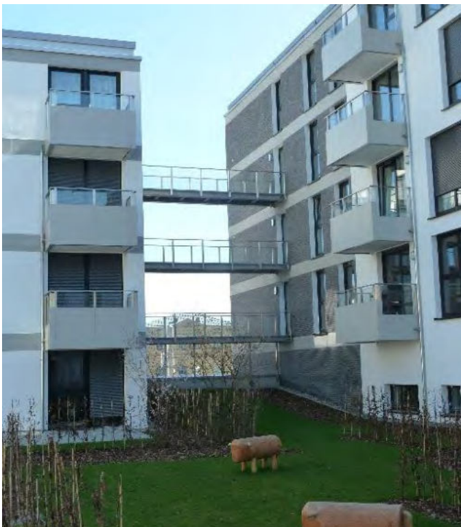
Baufortschritt, © RVI GmbH, Saarbrücken
