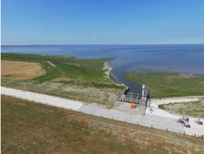
Blick von oben auf den Schweiburger Siel und das Auslaufbauwerk, © NLWKN
