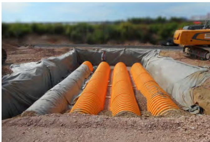
Unterirdisches Speichersystem, darauf Geotextil und Schottermaterial. Foto: Müller + Huber
