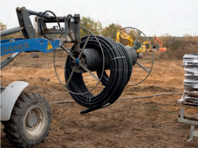
Werksgeschweißte Hochleistungs-Erdwärmesonde in Rollen
