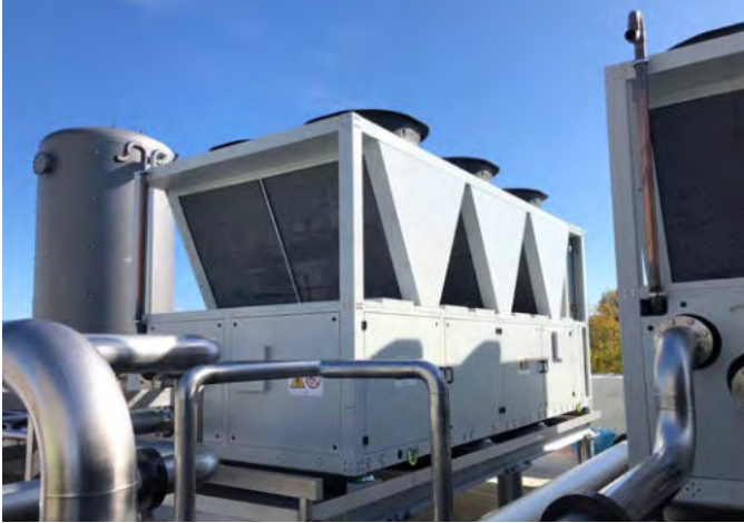
Bild 3: Flüssigkeitskühler (450 kW) für Prozesskühlung; Kältemittel R290 Propan
