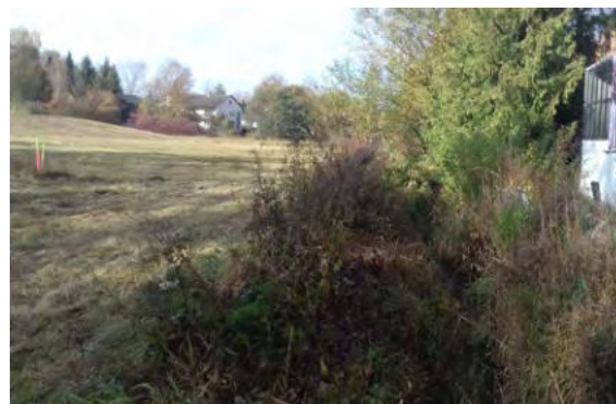
Vor der Renaturierung: der vollkommen verkrautete und zugewachsene Pulverriedgraben
