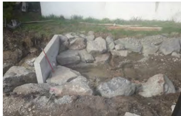
Im Zulaufbereich: Betonbauwerk mit 200 mm Durchlass unterhalb der Wasserlinie.
