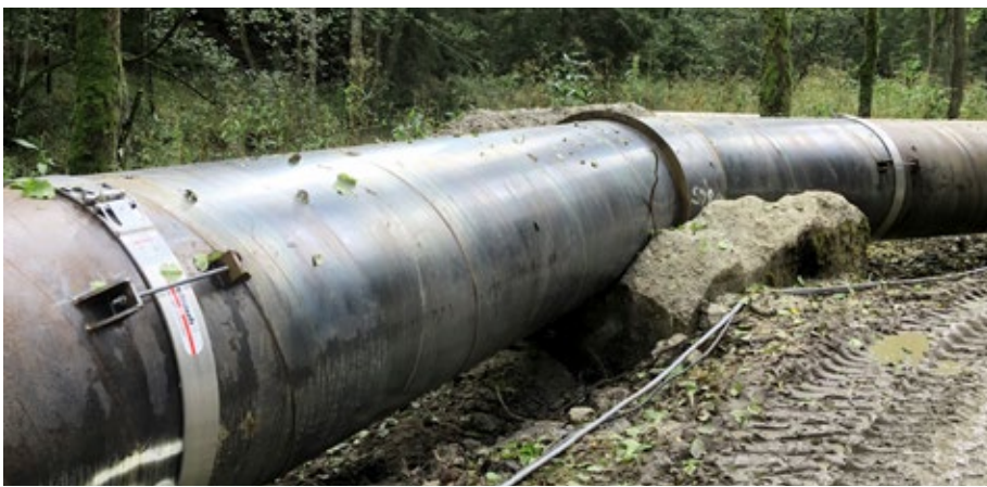
Bau einer Wetterunabhängigen Turbinenleitung ohne Schweißarbeiten
