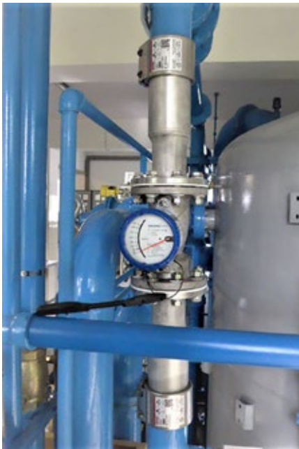
Nachträglicher Einbau eines Luftmengenmessers zum Oxidator
