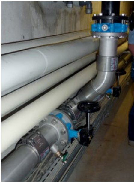
Sanierung einer Trinkwasserleitung in Edelstahl V4A
