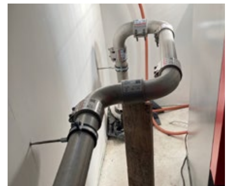
Beweglicher Großwasserhausanschluss
