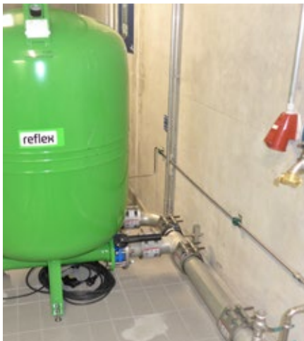
Umbau Druckmembran-Gefäß zur Verhinderung von Stagnation und Durchführung von Überprüfungsarbeiten
