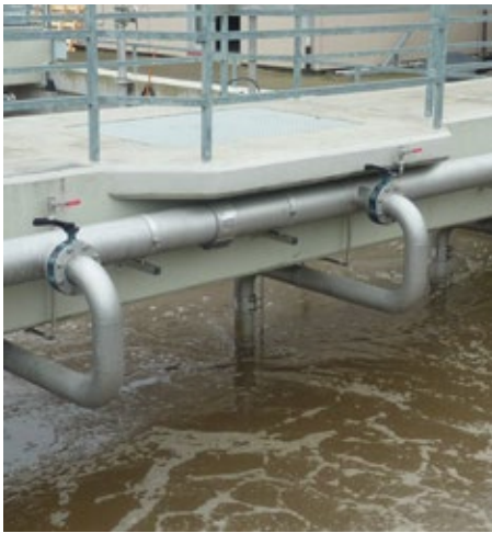
Kläranlage Luftleitung – Belüftungsbecken mit Flex Kupplung
