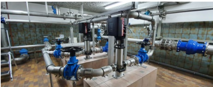
Sanierung einer Druckerhöhungsanlage
