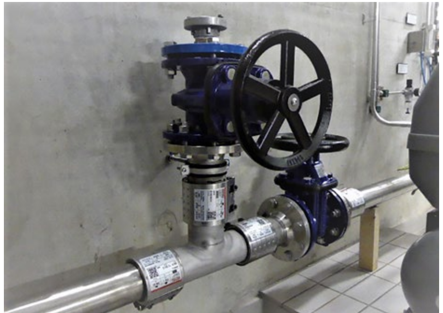
Nachträglicher Einbau einer Spüleinrichtung zu einer Wasseraufbereitungsanlage
