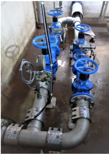
Sanierung einer Druckminderungsanlage
