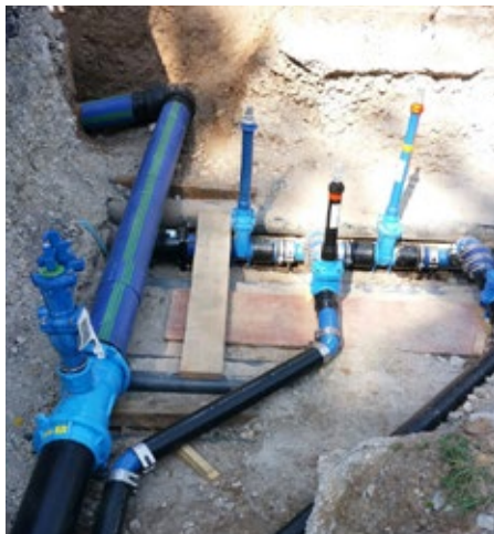
Wetterunabhängige, zugfeste Trinkwasserverrohrung in PE
