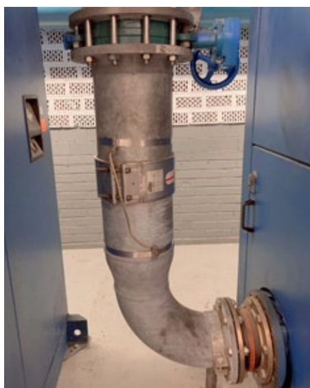
Verrohrung einer Kläranlage im Ex-Bereich ohne Schweißarbeiten
