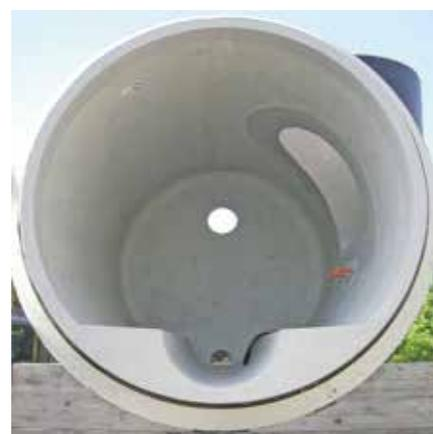
Stahlbetonrohr als Endrohr eines Stauraumkanals mit TWR und Tangentialschacht
