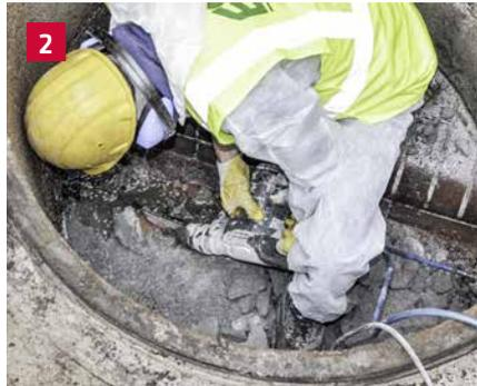
Gerinne und Berme ausstemmen, so dass der neue Schachtboden sohlgleich zu den Bestandsrohren gesetzt werden kann.
