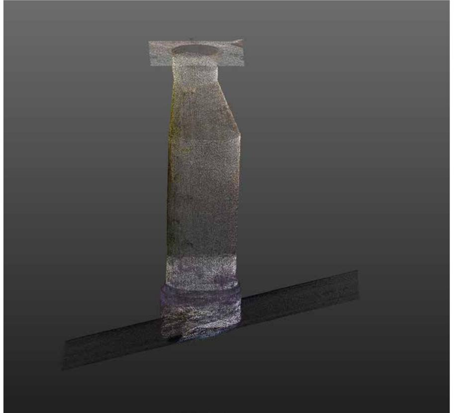
4m tiefer, gemauerter Schachtboden mit Betonringen und Konus
