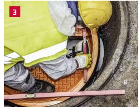
AWASCHACHT Schachtboden herablassen und mittels Absperrblasen ausrichten.
