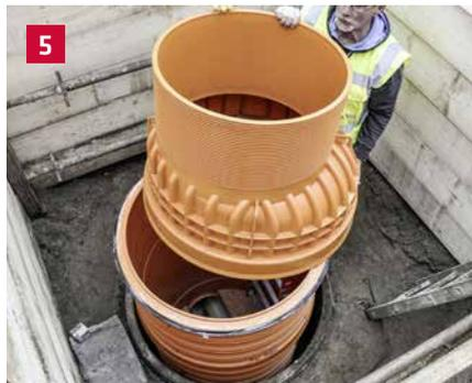
Schachtring und Konus aufsetzen und entsprechend verfüllen.
