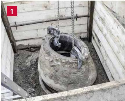
Altschacht: Konus abtragen, Schachtringe reinigen und ggf. abdichten, Steigeisen entfernen.
