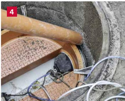
Den Ringraum zwischen Altschacht und AWASCHACHT mit REHAU Vergussmörtel verfüllen. Bereits nach ca. 45 min kann die Kanalleitung geöffnet werden.
