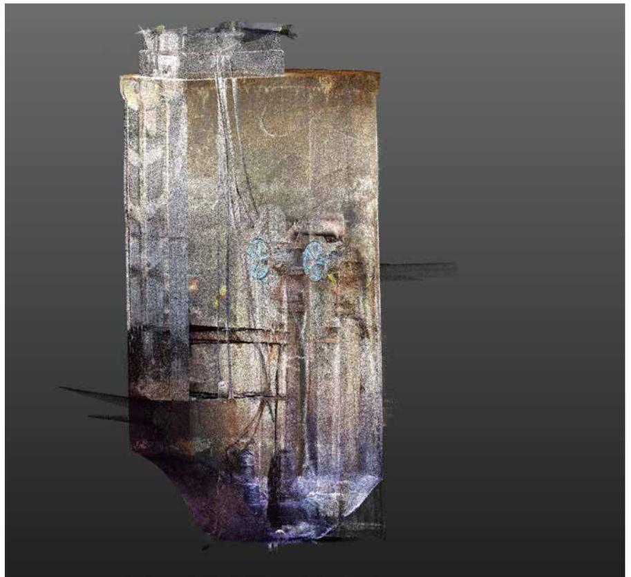
Pumpenschacht DN 2000 mit Doppelpumpanlage
