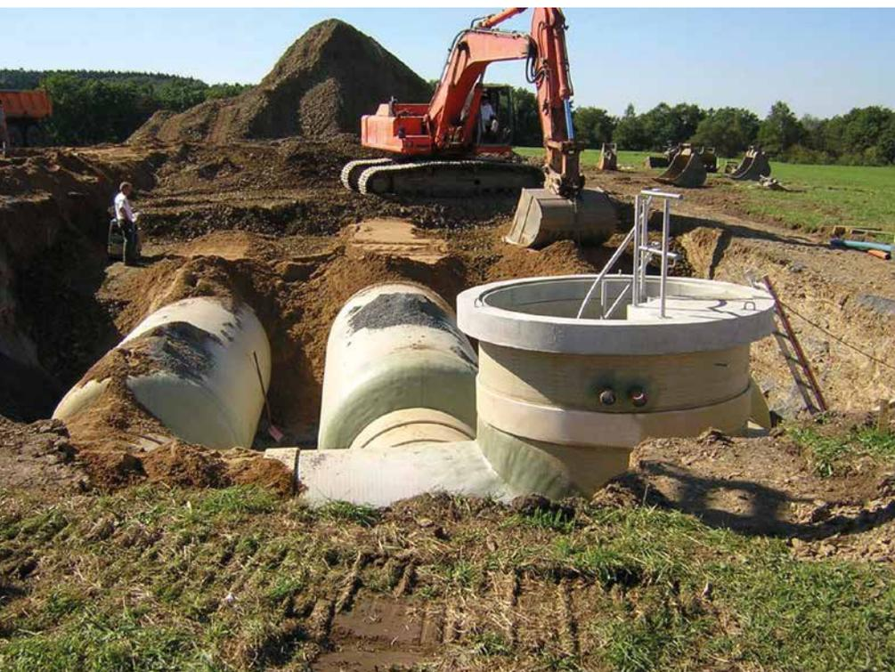
Die gute Verarbeitbarkeit von GFK, hohe Steifigkeiten und Festigkeiten bei großen Rohrdurchmessern und die besondere Eignung für das Trinkwasser machen das Produkt zu einem idealen Material für Trinkwasserspeicher. Dieser kann als liegende Röhre oder stehender Zylinder eingesetzt werden. Darüber hinaus lassen sich die großen Rohrdimensionen auch als Einhausung für komplexe Armaturenbereiche nutzen. In Kombination entstehen somit komplette Trinkwasserspeicheranlagen aus GFK.
