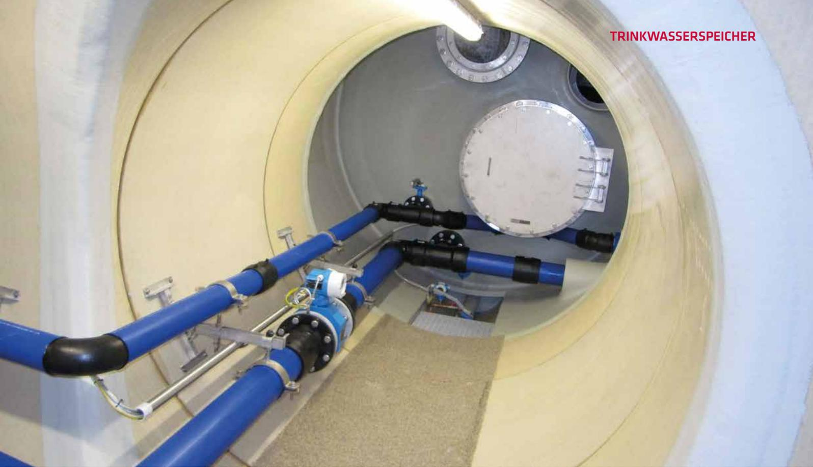
Anschläge sind integriert. Die vorgefertigten Module erleichtern so auch die spätere Armaturenverrohrung erheblich. Eingelassene Treppen und Türen sichern den späteren Zugang.
