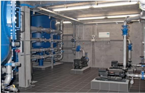
*Aktivkohledruckbehälter mit drei NKE-Normpumpen für die Beschickung und Rückspülung.*
