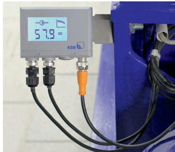
*Mit der digitalen Anzeige- und Auswerteinheit Pump-Meter hat das technische Betriebspersonal die Betriebsdaten der Pumpen im Blick sowie die Kontrolle, ob die Pumpen in einem optimalen Wirkungsgrad laufen.*
