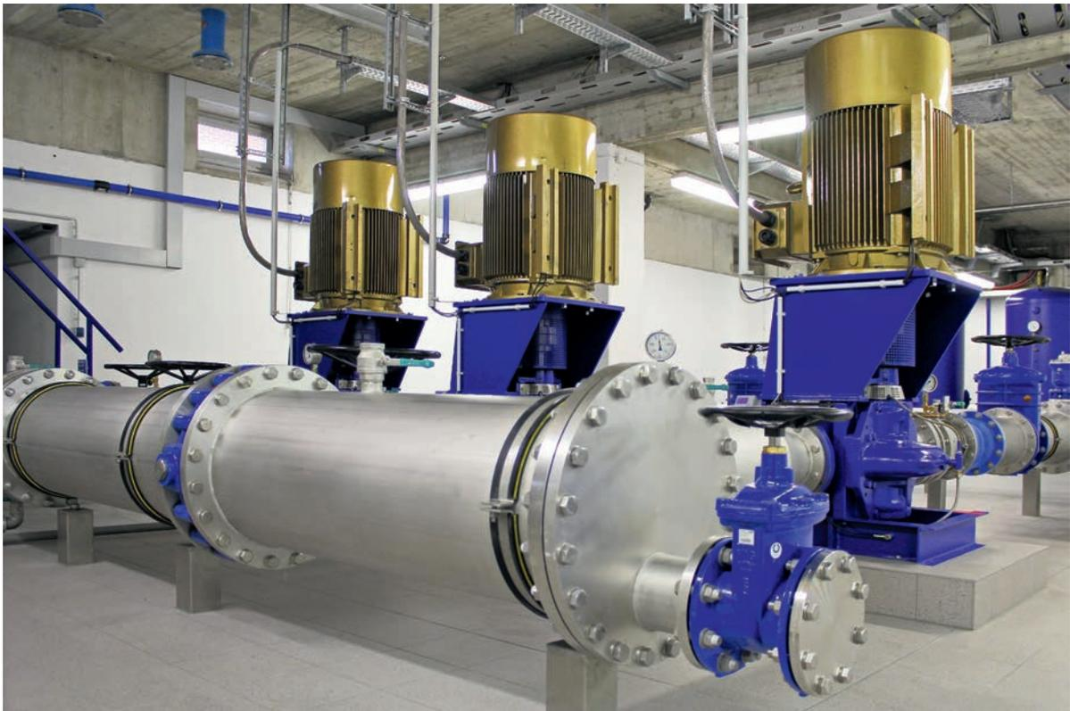
*Im Maschinenhaus Hart, dem Herzstück des niederbayerischen Wasserversorgungsunternehmens ZV Ruhstorfer Gruppe, werden die Pumpen von Synchron-Reluktanz-Motoren angetrieben, die auch im Teillastbetrieb noch optimale Wirkungsgrade erzielen.*
