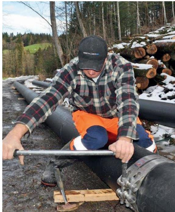
Schrauben mit Drehmomentschlüssel anziehen
