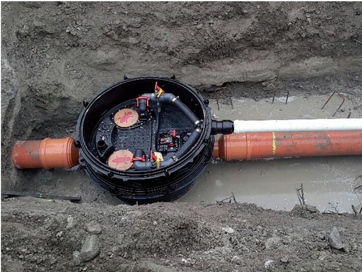
*Bild 6: Während des Einbaus wurde zunächst das Technikmodul der Hybrid-Hebeanlage in der Baugruppe platziert und angeschlossen.*
