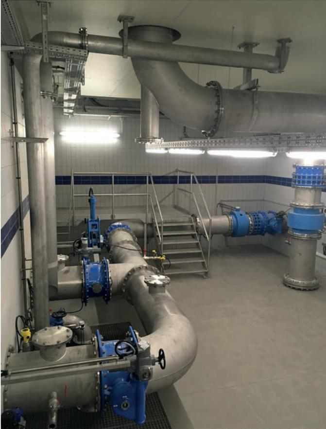
Rohrkeller im Wasserschloss Hattgenstein mit ERHARD Absperrklappen ROCO wave
