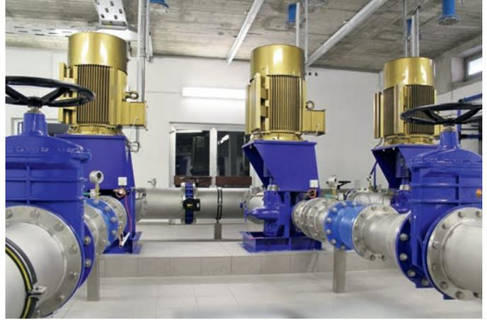
*Die vertikal aufgestellten Inlinepumpen der Baureihe KSB Omega ermöglichten eine geradlinige und damit strömungsoptimierte Anbindung der DN-300-Rohrleitungen. Automatische Drehzahlregelungen passen die Förderleistungen dem jeweiligen Bedarf an.*
