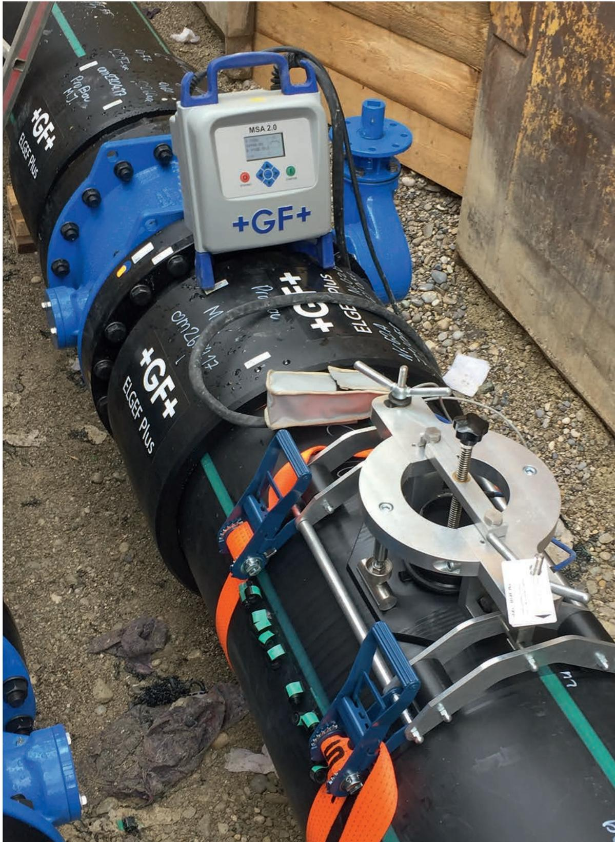
Über einen ELGEF Plus Anschlussattel wird die Leitung mit der im Keller angebrachten Übergabestation verbunden und diese versorgt die Büros und Haushalte mit gekühltem Wasser.
