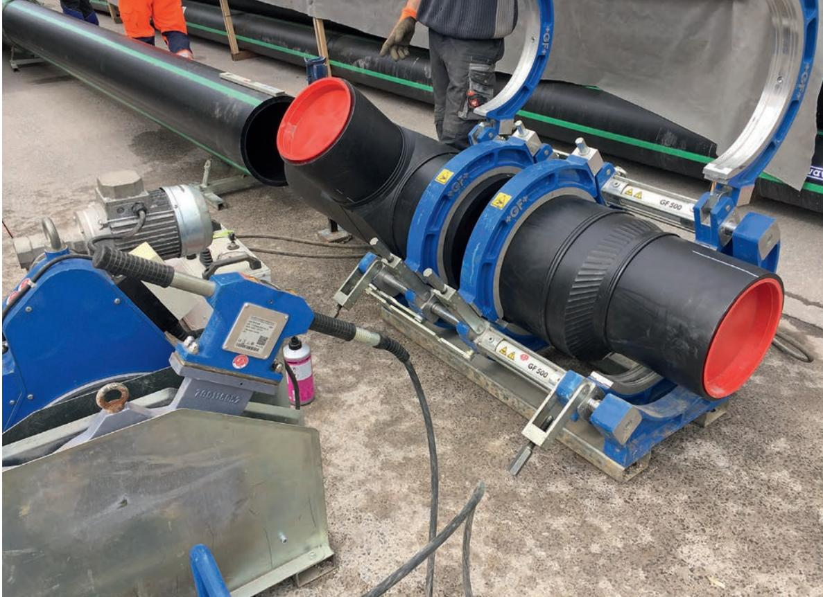
Die Stumpfschweißmaschine Typ GF 500 verbindet einzelne PE-Rohrkomponenten zu einer neuen Fernkälteleitung für die Münchner Innenstadt.
