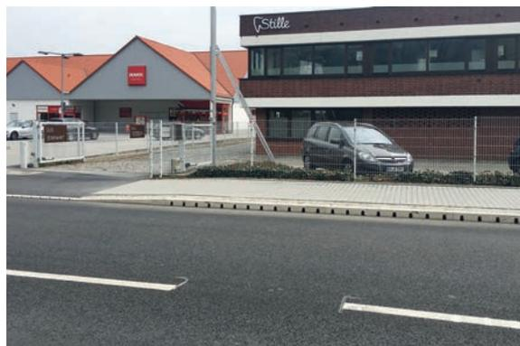
*Zwei Funktionen – eine Lösung: die ACO DRAIN® KerbDrain, eine Kombination von Bordstein und Entwässerungsrinne*
