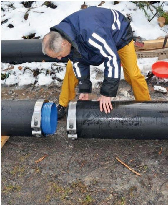
Verbinder einstecken und PE-Rohre verbinden
