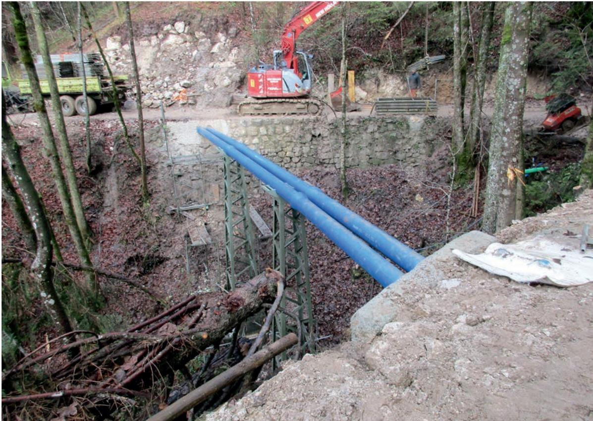
Die Leitung, bestehend aus alten Stahl-Büchsen- (Stahlmuffen-)Rohren und Graugussrohren (die ältesten von 1844), wird als Zuleitung für sauberes Quellwasser genutzt, welches für das „nasse Abbaufahren“ zur Solegewinnung im Salzbergwerk notwendig ist.
