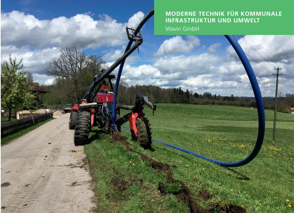
Zudem sind die Rohre direkt schäl- und verbindungs-fertig. Beim Einbau lässt sich das Wavin TS<sup>DOQ</sup> wie ein Standard-PE-Rohr verarbeiten. Es sind keine zusätzlichen Arbeiten zur Entfernung oder Rekonstruktion von Schutzumhüllungen nötig. Darüber hinaus ist das Produkt durch DIN CERTCO nach PAS 1075 zertifiziert. Das Rohr kann daher für den Pflug-, Fräs- und Horizontalpülbohrenbau sowie für alle anderen alternativen Verlegemethoden in fachgerechten Anwendungen eingesetzt werden.
