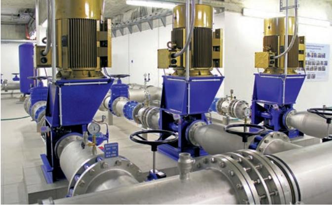
*Energieeffizienz in der Wasserversorgung: In einem Trinkwasser-Pumpwerk des Zweckverbandes Wasserversorgung Ruhstorfer Gruppe reduziert die Antriebstechnologie der Synchron-Reluktanz-Pumpenmotoren den Pumpenstromverbrauch um rund 20 %.*
