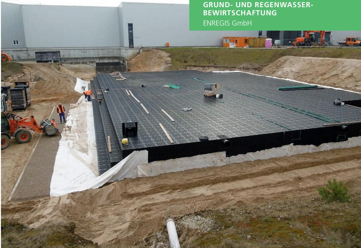
Nahezu fertiggestellte ENREGIS Hochlast Regenwasserversickerungsanlage im Projekt CLASSEN, Baruth
