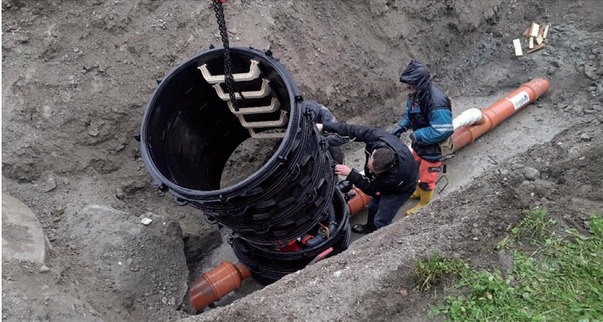
*Bild 7: Das Schachtmodul wurde am aufgeschweißten Schachtring des Technikmoduls montiert. In nur einem Tag konnte der gesamte Einbau abgeschlossen werden.*
