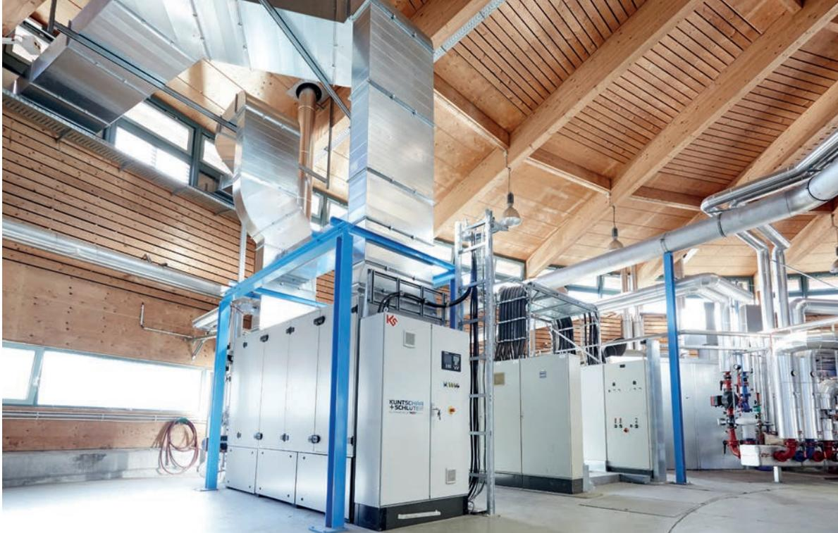
Installation eines neuen 150-kWel.-BHKW in das bestehende Maschinengebäude
