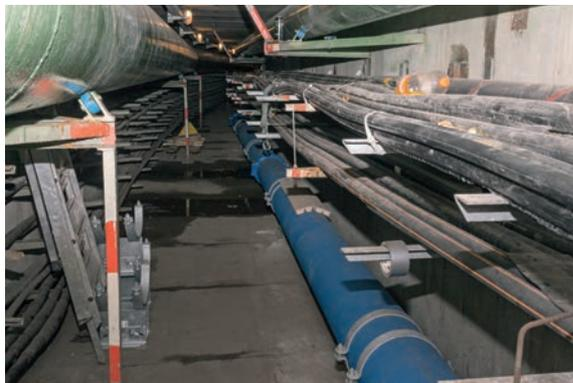
*Schweißen unmöglich: Stromkabel und Gasleitungen sind in einem Kanal verlegt.*
