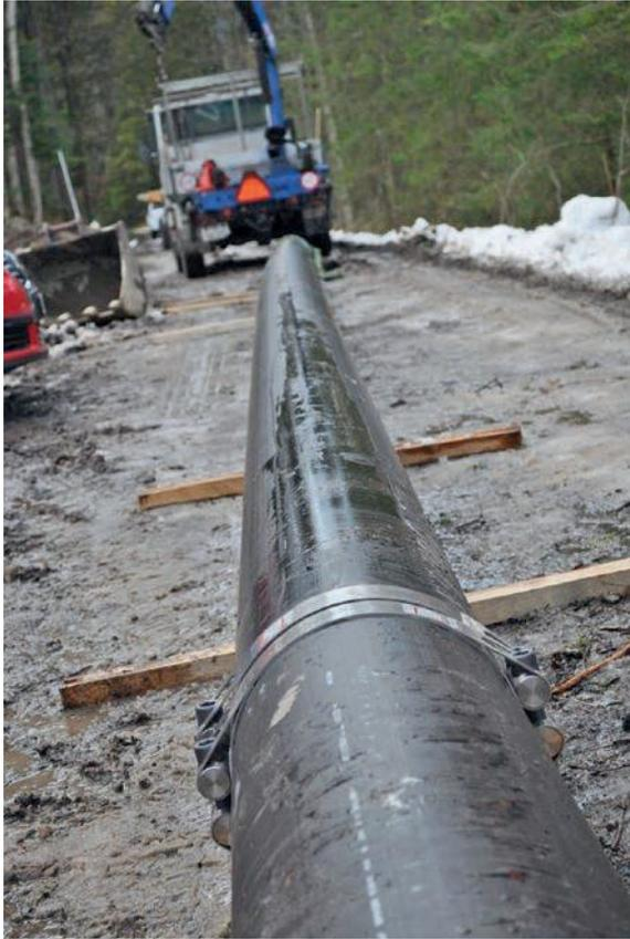
*Die vormontierten Rohre wurden zur bereits vorbereiteten Baugrube gezogen ...*
