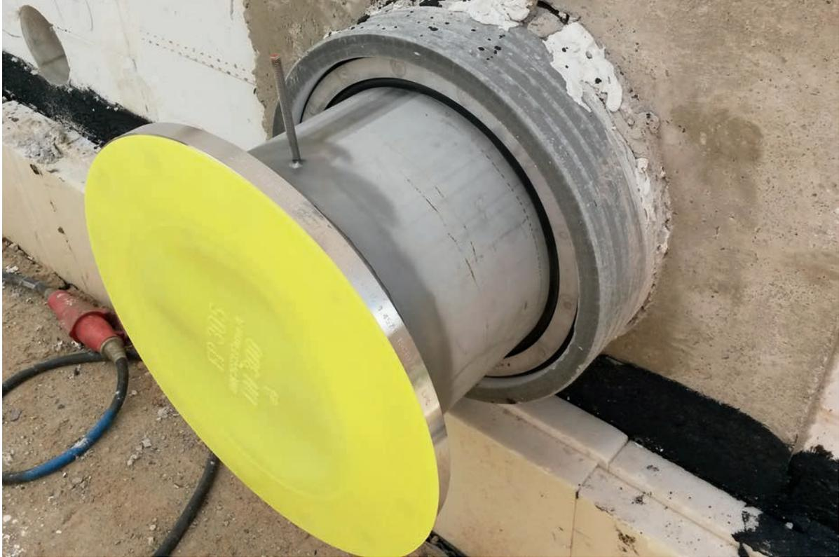
Einbau Curaflex® Futterrohr 3000 und Curaflex® A (DN 400) in gegossenen Beton
