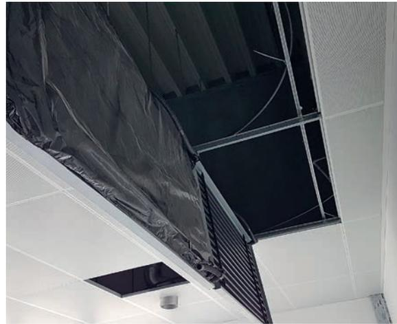
Die aktive Heiz- und Kühldecke wurde in beiden Etagen installiert. Im Erdgeschoss wurden 808 Register verbaut, was einen aktiven Flächenanteil der Heiz- und Kühldecke von ca. 500 m<sup>2</sup> ergibt. Im Obergeschoss wurde mit 1.248 verbauten Registern ein aktiver Flächenanteil von ca. 725 m<sup>2</sup> geschaffen.
