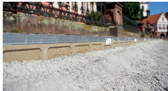
*Die Kombination aus dem Werkstoff ACO Polymerbeton und der Dichtung sorgt für einen durchgehend dichten Rinnenstrang gemäß den Anforderungen der DIN EN 1433/DIN 19580.*
