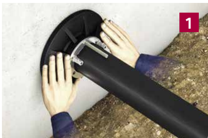
Positionieren der Hauseinführung
