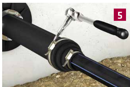
Montage des Endstopfen
