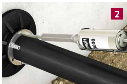
Einbringen des Expansionsharzes
