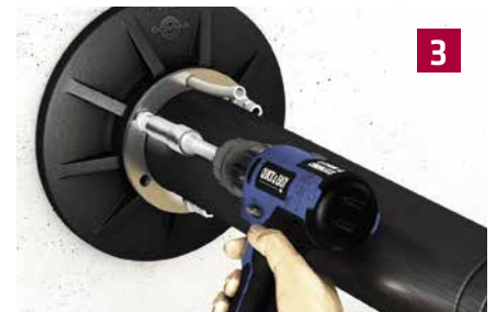
Verspannen der Außenabdichtung
