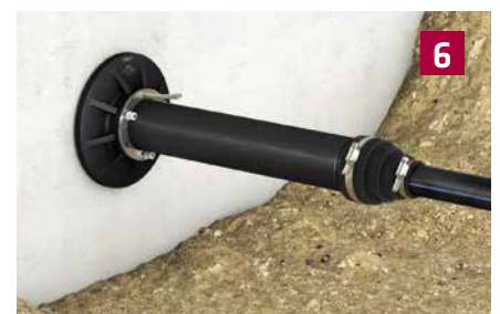
Fertig eingebaute Hauseinführung
