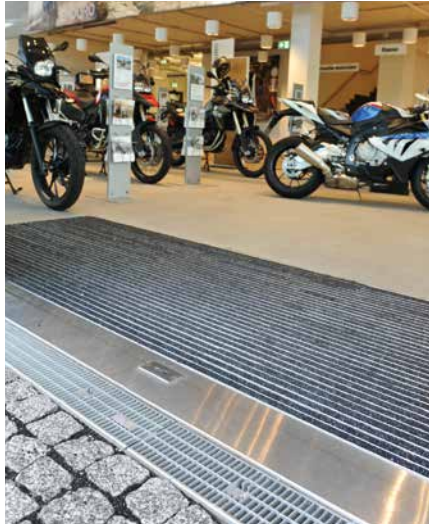
Barrierefreie Übergänge mit Gitterrosten der Maschenweite 10/30 aus V2A Stahl und der Belastungsklasse E 600.
