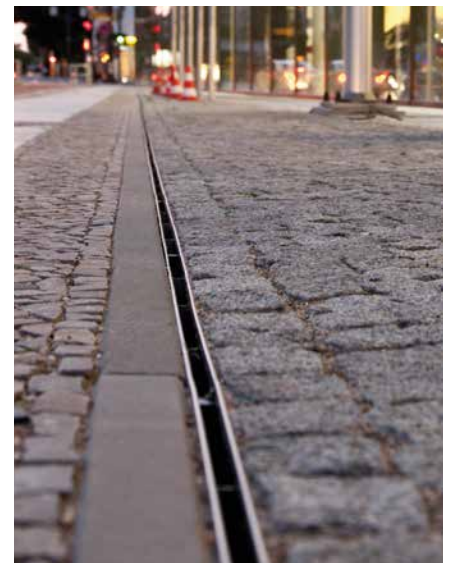
Rinnensystem der Nennweite 100 mit asymmetrischen Schlitzaußensätzen aus 1,8 mm V2A Stahl und der Schlitzweite 18 mm.
