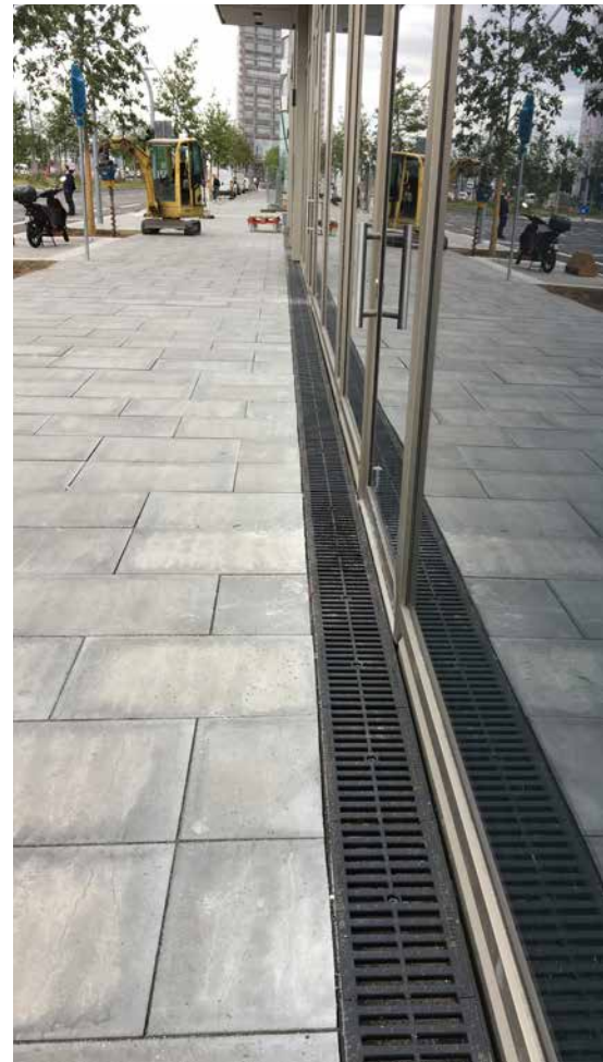
Fassadenentwässerung im Intelligent Quarters nahe der HafenCity in Hamburg.
