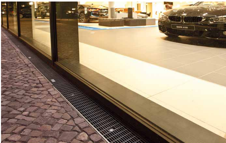
Fassadenentwässerung mit Gitterrosten der Maschenweite 30/10 und der Belastungsklasse C 250.
