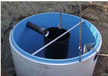
Sedimentationsanlage MSA 2500 und MSA 3000
