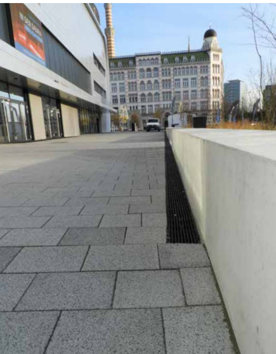
Korrosionsfreies Rinnensystem RECYFIX PRO entwässert den Eingangsbereich der neuen Ballsportarena in Dresden
