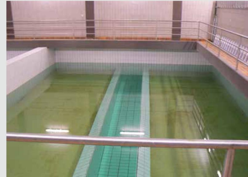
Fachexkursion mit Studierenden: Sandfilteranlage zur Entfernung von Eisen und Mangan für die Trinkwasseraufbereitung bei der Wasserversorgung Bayerischer Wald
