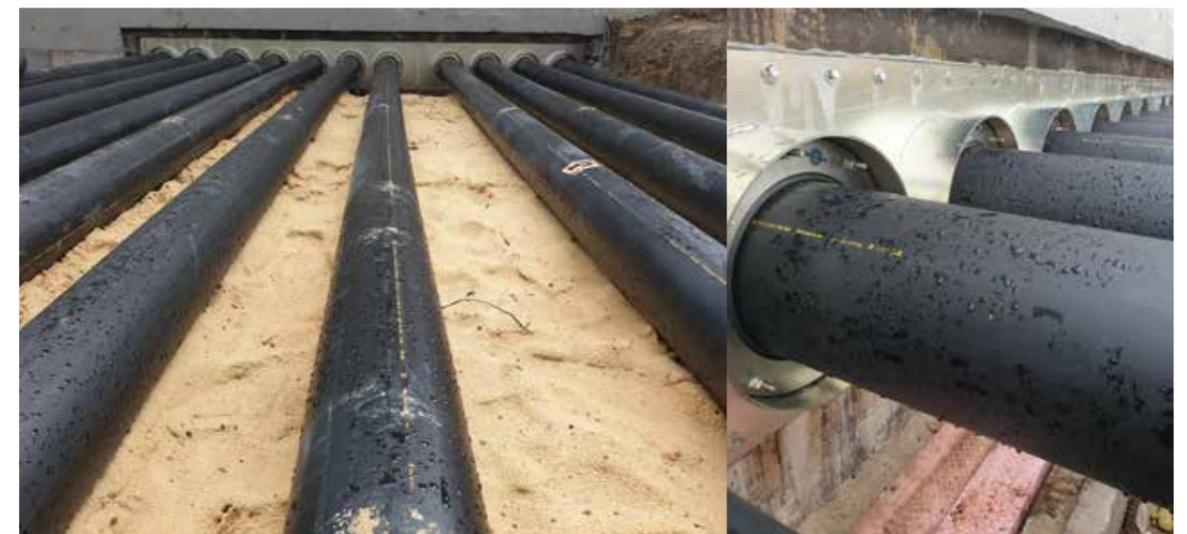
Tankseitig wurde eine Plattenkonstruktion des Typs Curaflex® 8000 inklusive elf Curaflex® C-Dichtungseinsätzen verbaut
