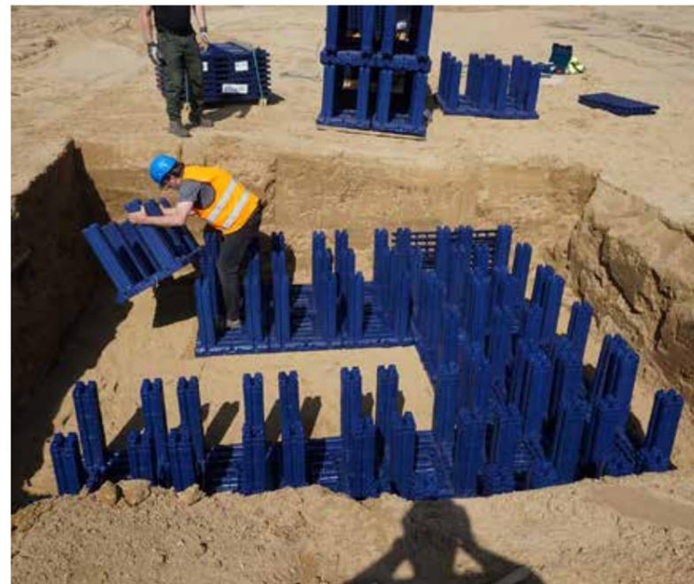
Der Einbau des auf dem modularen Versickerungs- und Rückhaltesystem Wavin Q-Bic Plus basierenden TreeTanks trägt dazu bei, dass die Wurzeln von der Oberfläche in die Tiefe gelenkt werden. Dort finden sie gleichermaßen genügend Wasser wie Nährstoffe und verankern sich fest gegen Windlast.
