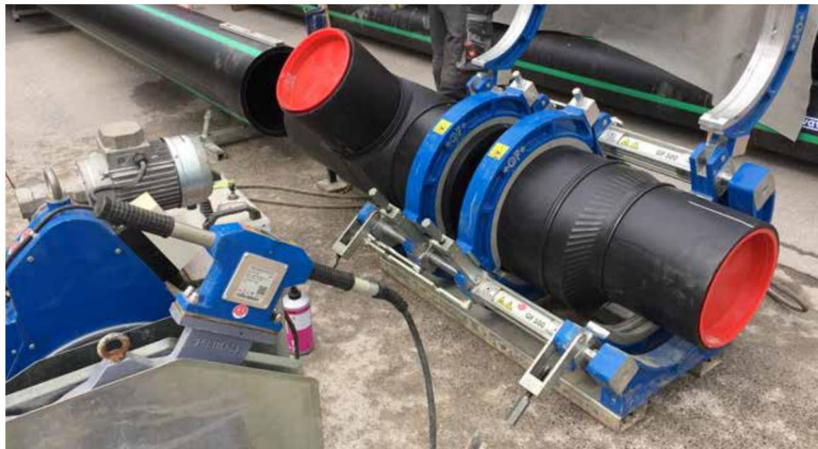
Die Stumpfschweißmaschine Typ GF 500 verbindet einzelne PE-Rohrkomponenten zu einer neuen Fernkälteleitung für die Münchner Innenstadt.
