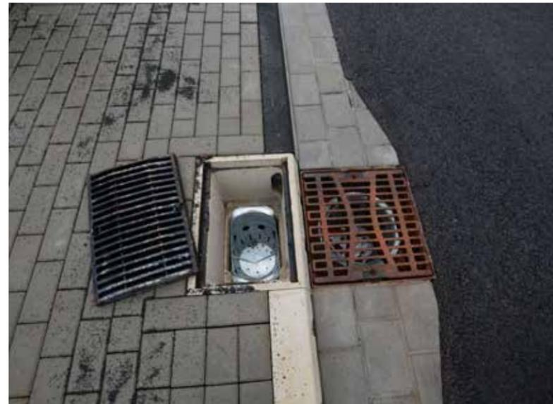
ACO Drain®Box mit doppelter Sicherheit und Kapazität
