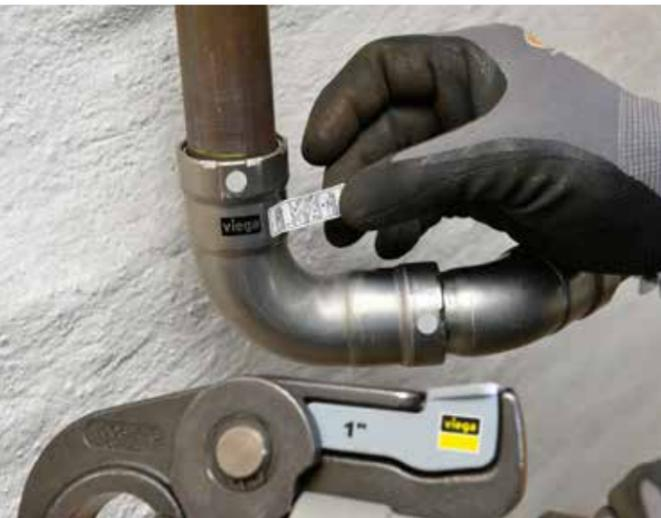
Das Rohrleitungssystem „Megapress S“ macht die Installation von Nah- und Fernwärmenetzen ab Gebäudeeintritt durch die Pressverbindungstechnik deutlich wirtschaftlicher und sicherer.
