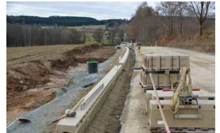
Sanierung der Staatstraße 2693 mit der ACO DRAIN® KerbDrain Road. Sie vereint den Bordstein mit der Entwässerungsrinne in einem Bauteil.
