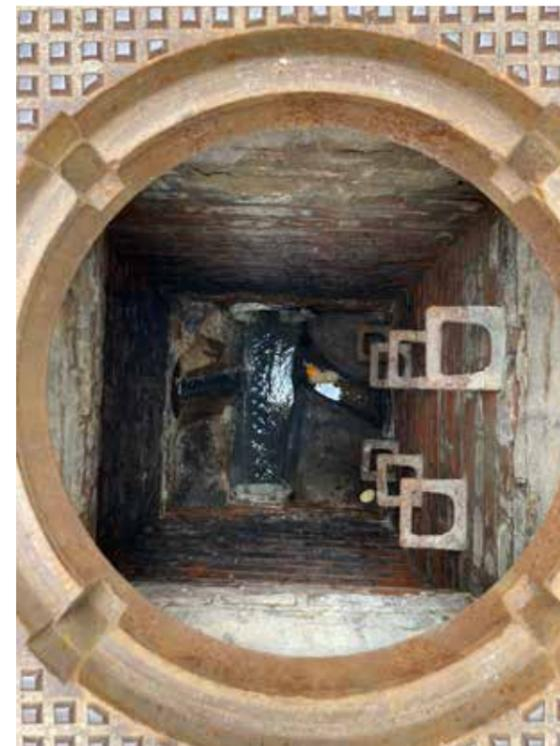
Eckige, korrodierte, undichte gemauerte Schächte
