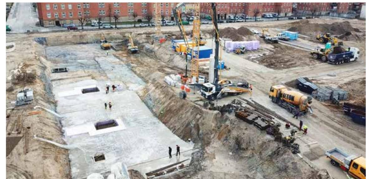
Abbildung 6: Verlegung der Erdwärmekollektoren im Baugebiet „Lagarde Campus“. Bildquelle: Steinhäuser GmbH & Co. KG
