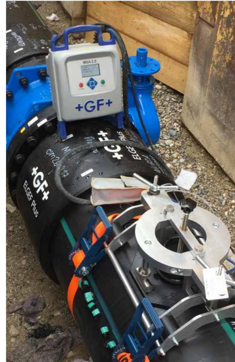
Über einen ELGEF Plus Anschlusssattel wird die Leitung mit der im Keller angebrachten Übergabestation verbunden und diese versorgt die Büros und Haushalte mit gekühltem Wasser. Foto: Georg Fischer
