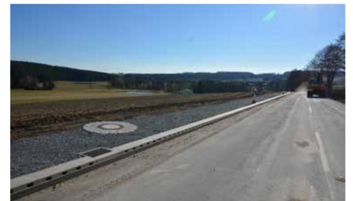
ACO DRAIN® KerbDrain Road - Entwässerung im Randbereich
