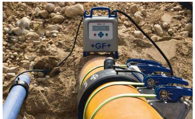
ELGEF Plus ist das Elektroschweiß-System für PE-Druckrohrleitungen
