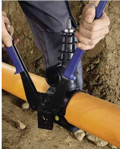
Armatur mit Handwerkzeug oder Pressgun verpressen.
