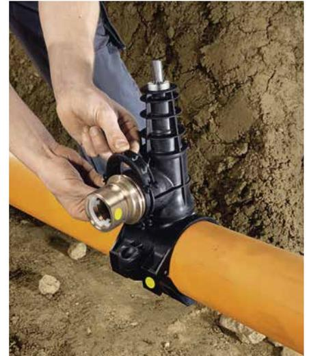
Geopress G-Anschlussstück einsetzen und sichern.
