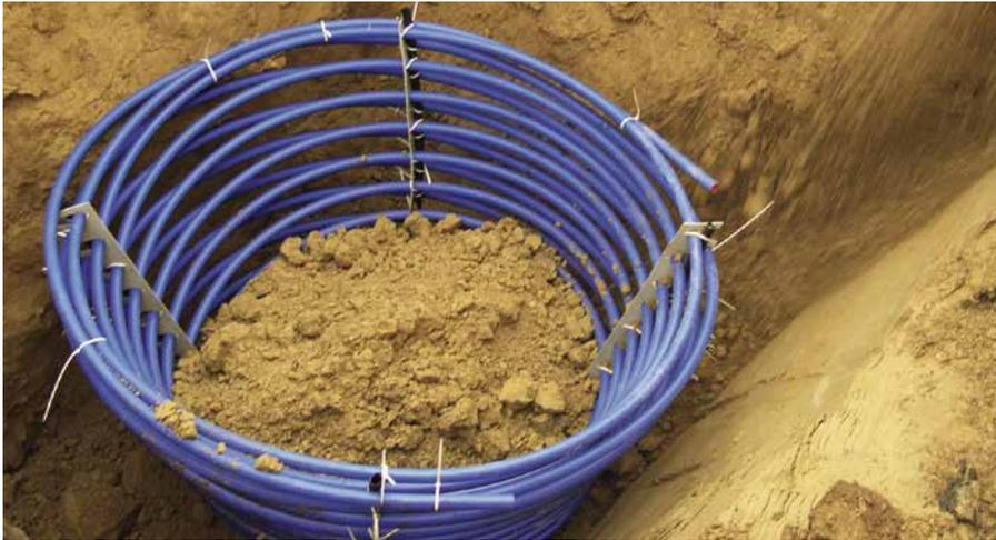
Erdwärmekörbe fördern die Wärme der oberen Erdschicht.
