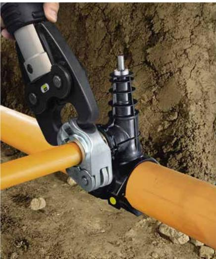
Hausanschlussleitung verlegen, verpressen und anschließend Druckprobe durchführen.
