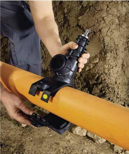
Anbohrarmatur aufsetzen und in erste Raste einrasten.
