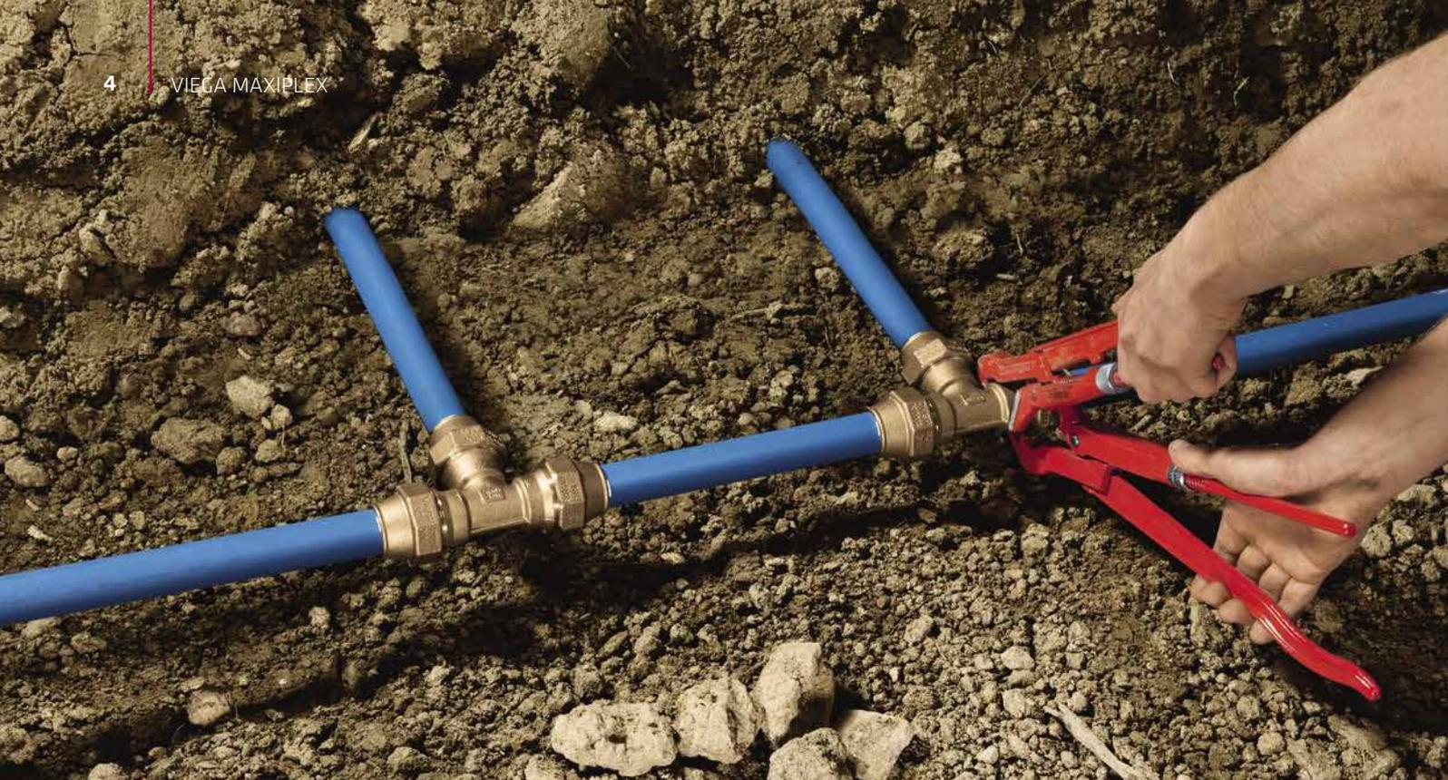
Viega Maxiplex bietet den entscheidenden wirtschaftlichen Vorteil: Die Klemmverbinder für die Trinkwasserversorgung sind mit wenig Werkzeug schnell montiert.
