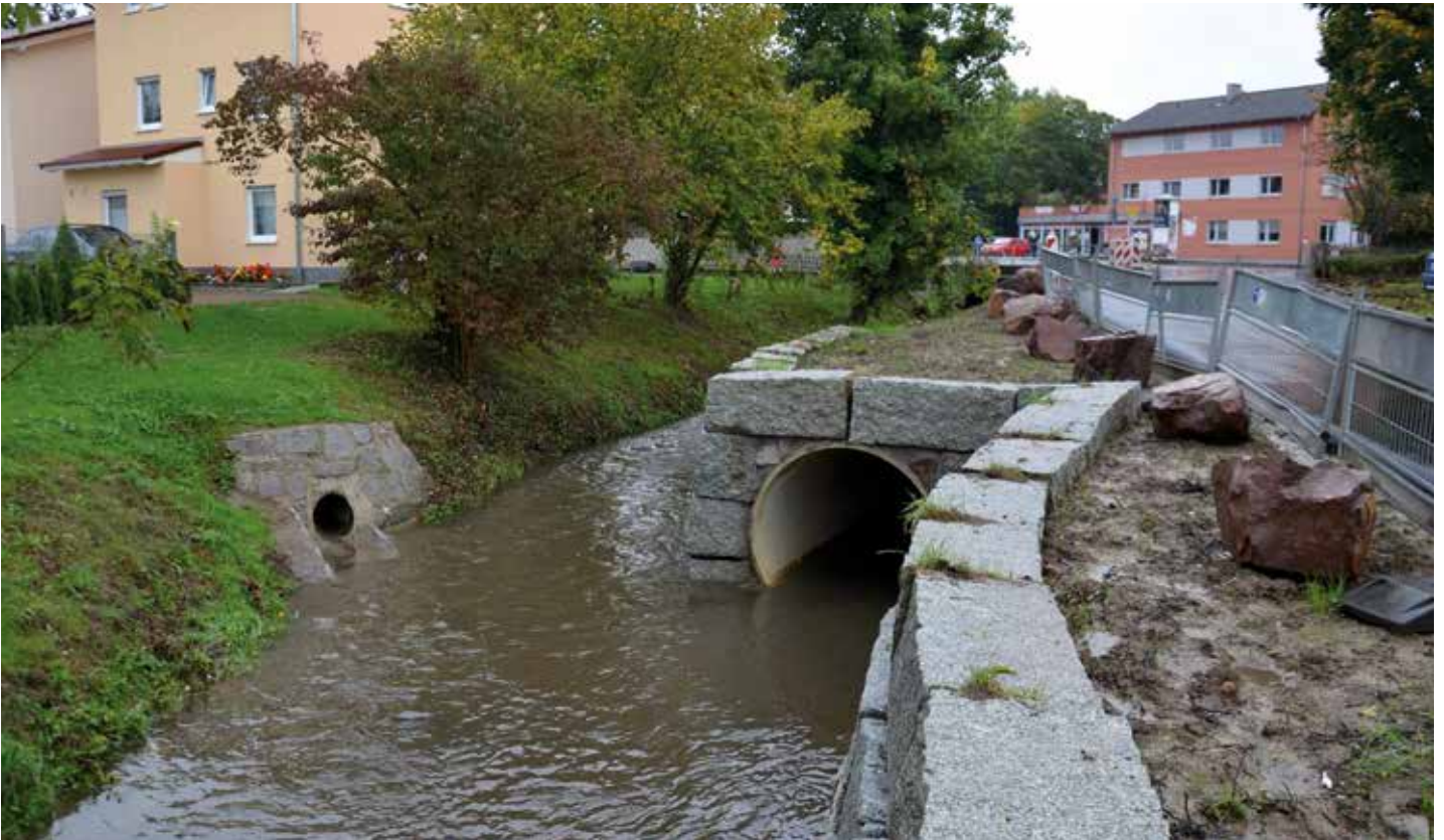
Einmündungsstelle des neuen Regenwasserkanals (rechts im Bild) in die Vorflut »Sulzbach«. Foto: Funke Kunststoffe GmbH
