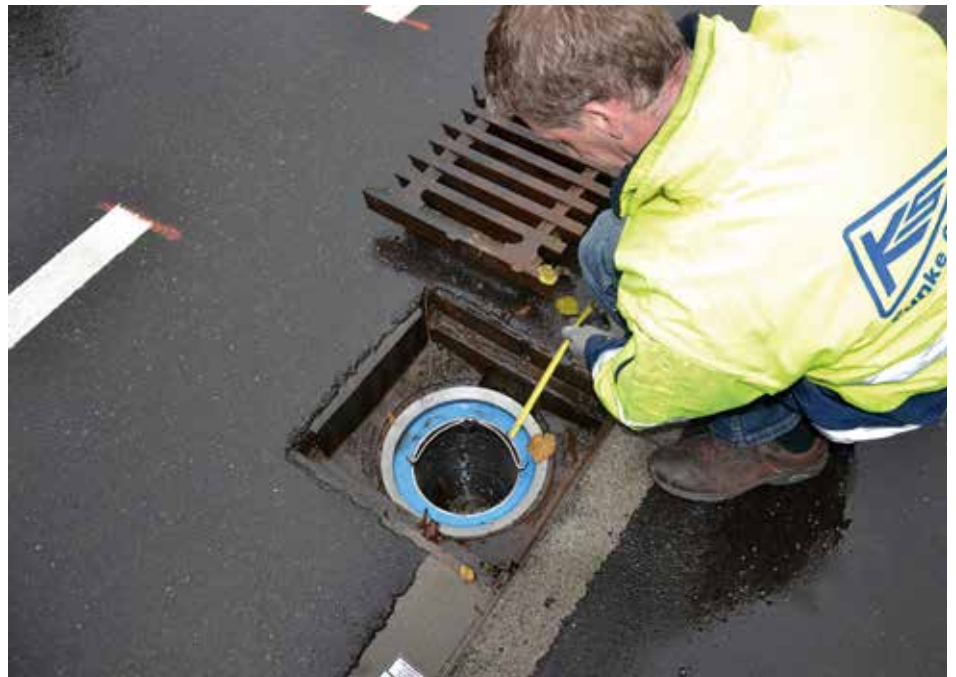
Ein Mitarbeiter der Firma Funke demonstriert das leichte Wechseln des Filters.
