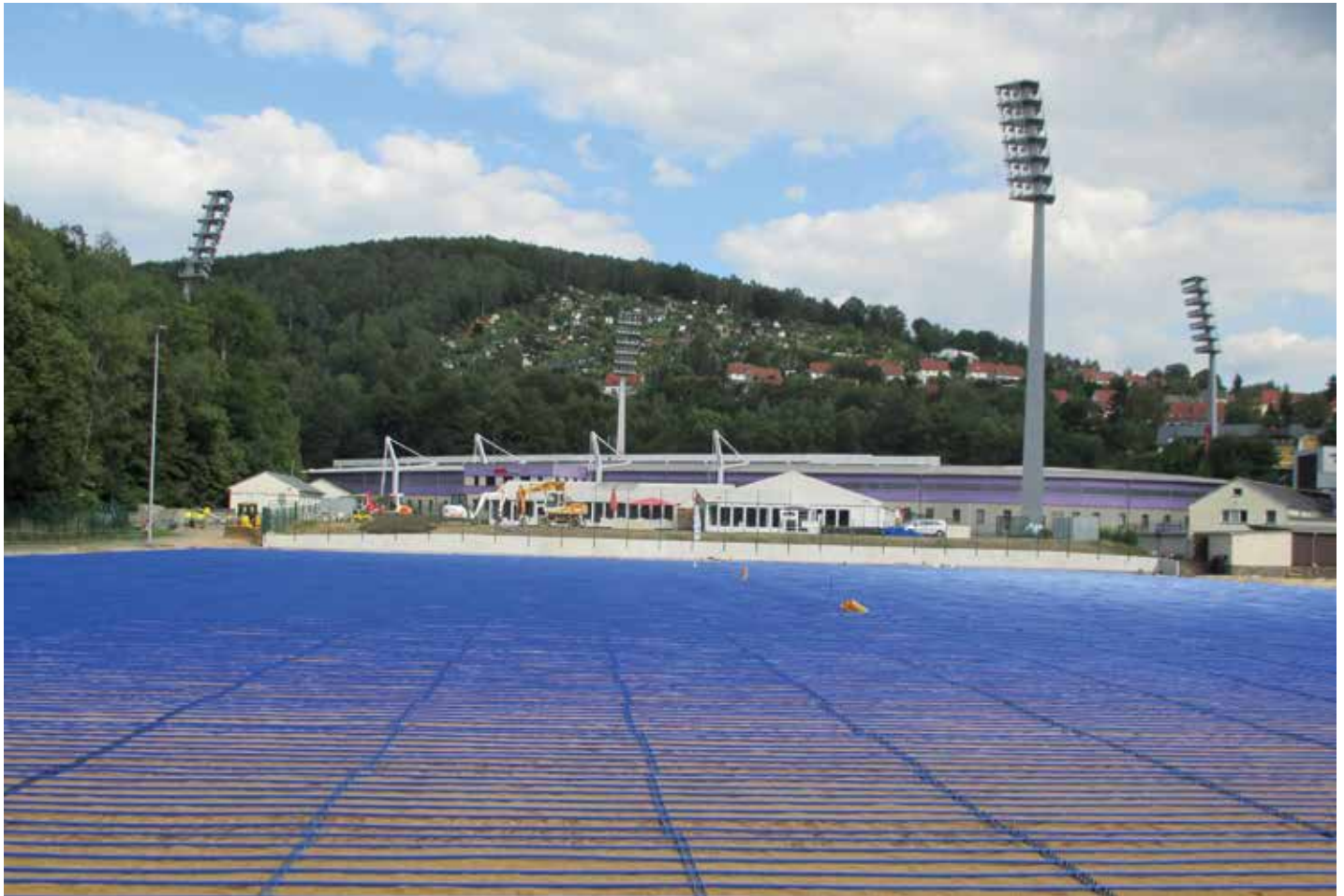
Rasenheizungen schaffen auch im Winter optimale Trainings-Grundlagen. (Quelle: aquatherm GmbH)
