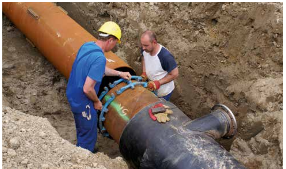
Durch diese Leitung fließen bis zu 1,4 Mio. Liter Abwasser pro Stunde. (Quelle: IKEA/bwp)
