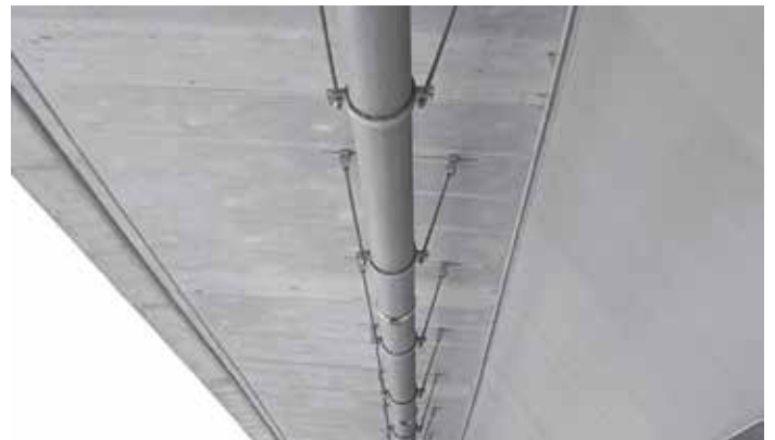
Das Düker MLB-Rohrsystem im Einsatz. (Quelle: Düker)
