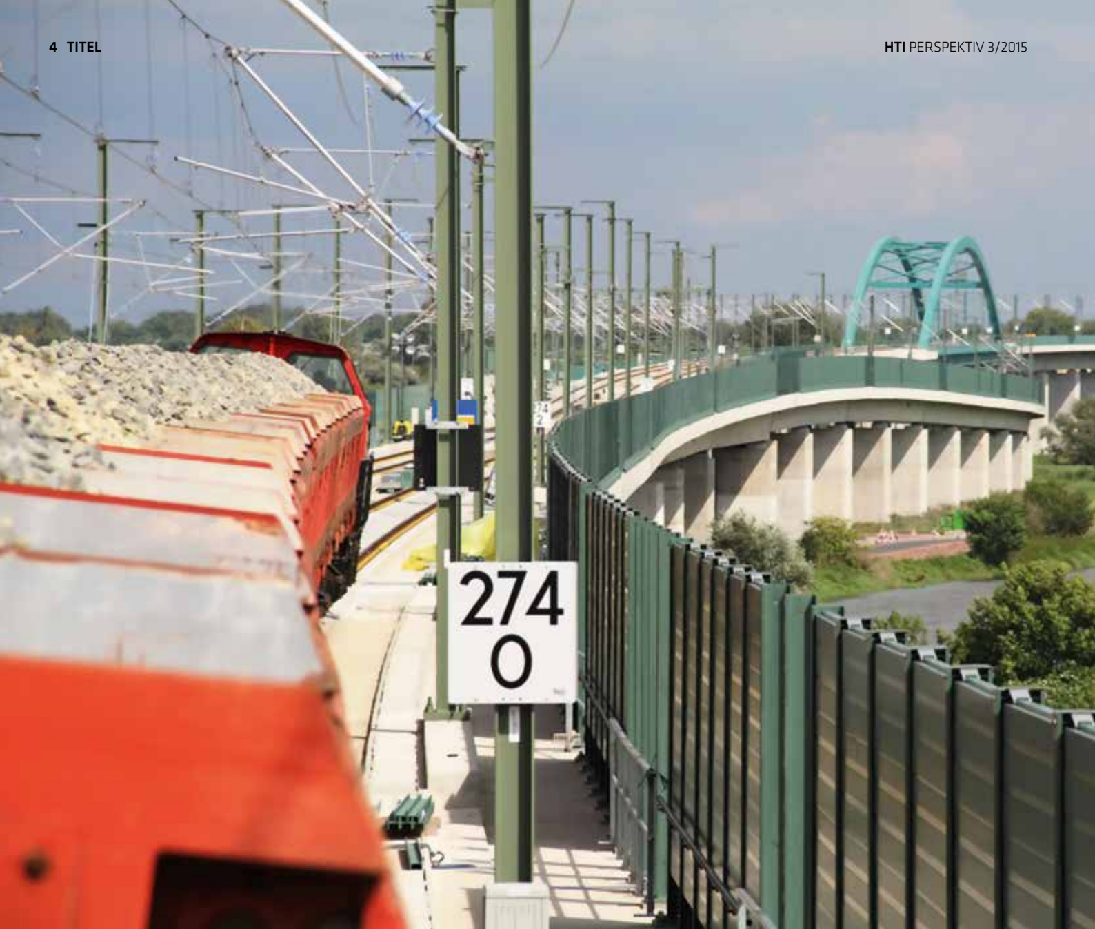
Belastungstest für die neu gebaute Saale-Elster-Talbrücke (Quelle: DB AG).
