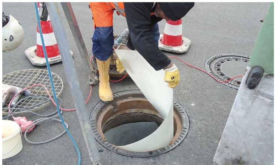
Praxisfall Sanierung in Dietzenbach: Vorgefertigte GFK-Platten wurden über die Schachtöffnung in die bis zu fünf Meter tiefen Bauwerke eingebracht und mit Edelstahlschrauben an der Schachtwand befestigt. Die Plattenstöße und Schraubenköpfe erhielten einen Überzug aus Handlaminat. Die Verkleidung schließt an der oberen Schachtabdeckung ab und nach unten bei den angebrachten Rohren. (Quelle: Geiger Unternehmensgruppe)
