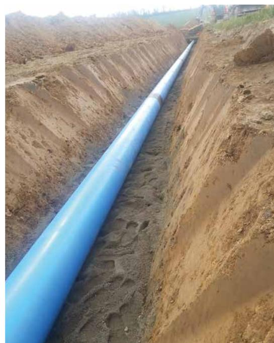
Abgeböschtes Rohrgrabenprofil und 406,4 x 5,00 mm Stahlrohr (Quelle:HTI COLLIN KG)
