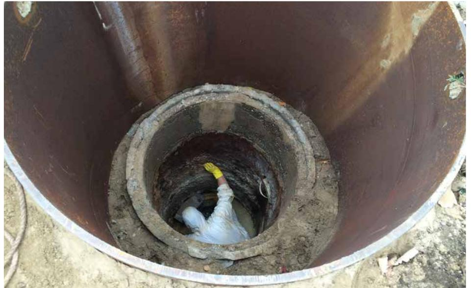
Sanierung mittels Schacht in Schacht-System unter Verwendung des Schnellvergussmörtels »Topolit Fix Super« zur raschen Wiederinbetriebnahme. (Quelle: P & T Technische Mörtel GmbH & Co. KG)
