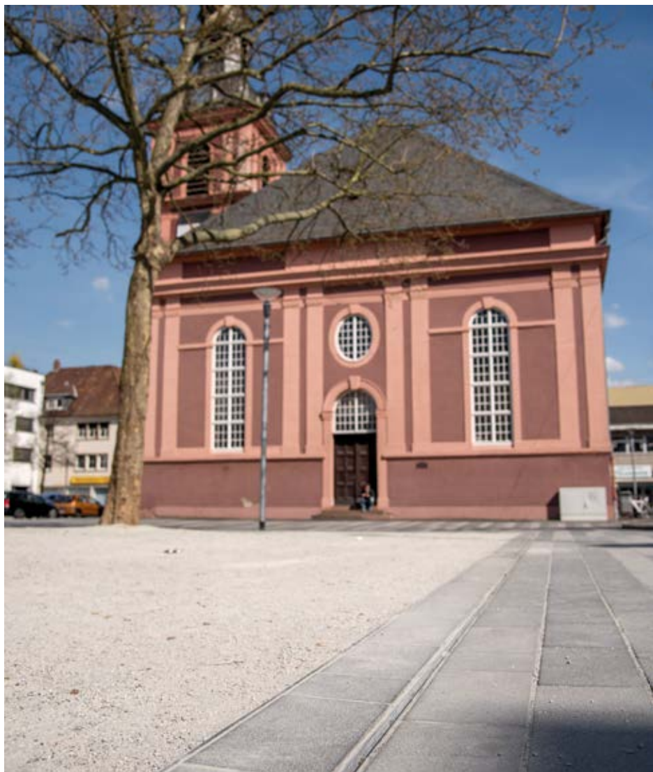
An der Oberfläche ist nur ein schmaler Schlitz sichtbar. Die Rinnen fügen sich auf diese Weise dezent in die Architektur ein. (Bild: Hauraton)
