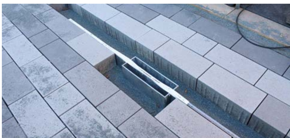
Über den Revisionskasten bleibt der Rinnenstrang zugänglich und kann gewartet und gereinigt werden. (Bild: Hauraton)
