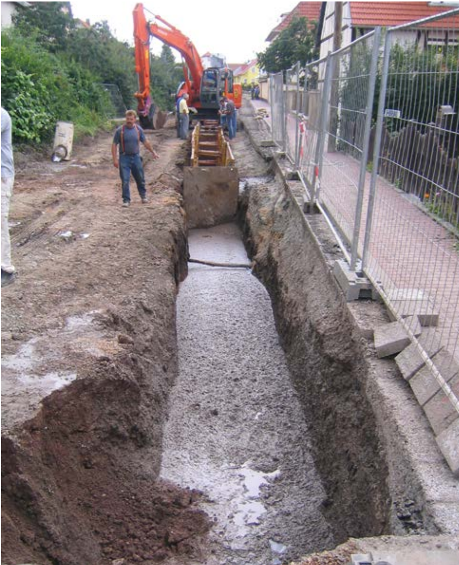
Flüssigboden kann hohlraumfrei und ohne zusätzliche Verdichtungsarbeiten eingebaut werden – das spart Zeit und Geld. (Bild: Ingenieurbüro John & Stolze GmbH)
