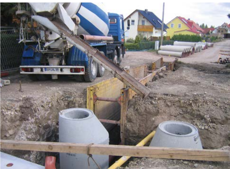
Flüssigböden können in mobilen oder stationären Anlagen hergestellt werden, bevor sie an der Baustelle wieder verfüllt werden. (Bild: Ingenieurbüro John & Stolze GmbH)
