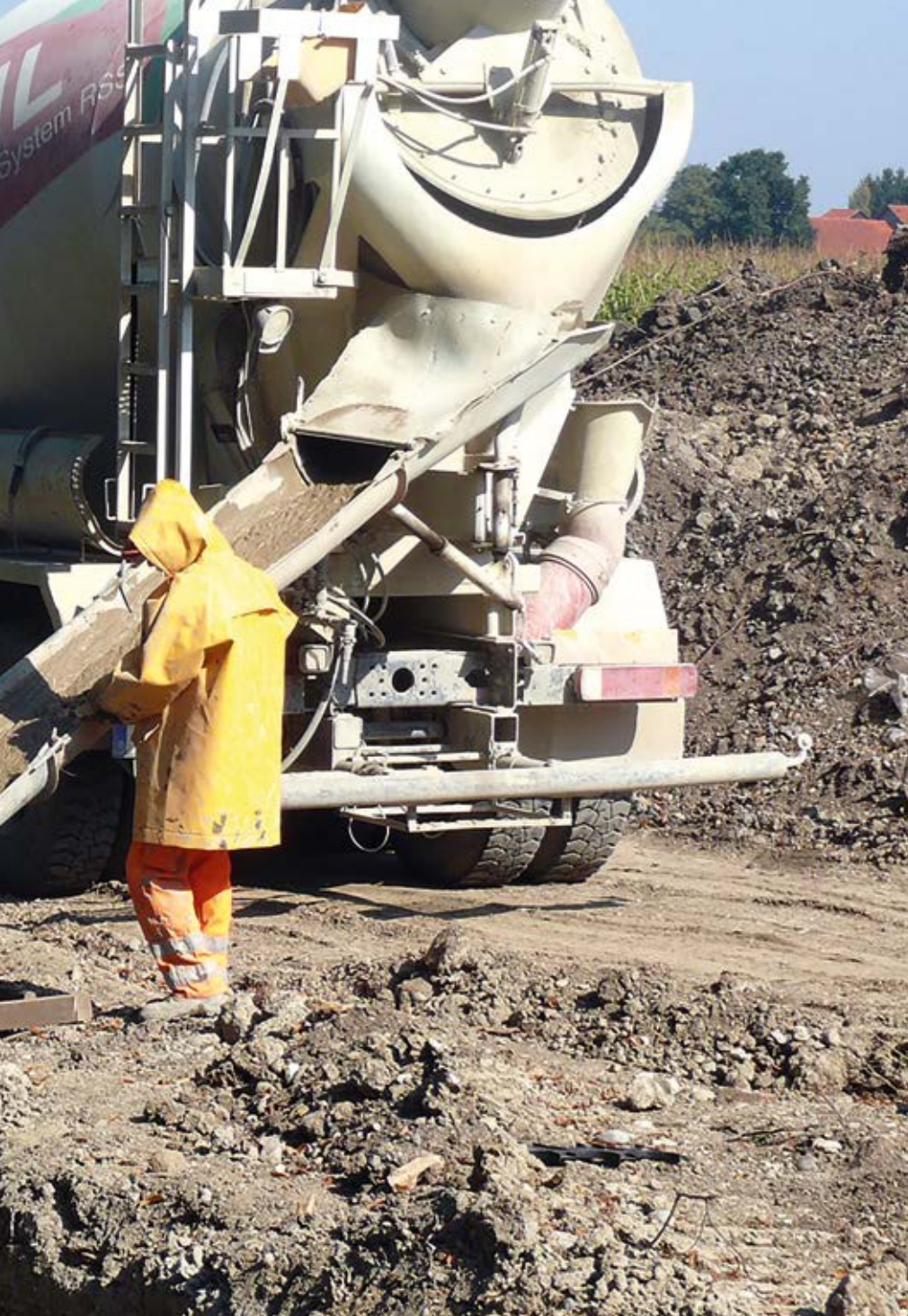
Flüssigboden kommt immer häufiger zum Einsatz – hier wird er zur Verfüllung einer Fernheizungstrasse bei Ulm verwendet. (Bild: RAL Gütergemeinschaft Flüssigboden e.V. Leipzig)
