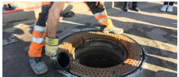
Einbau einer Schwerlastabdeckung. (Bild: HTI DINGER & HORTMANN KG)
