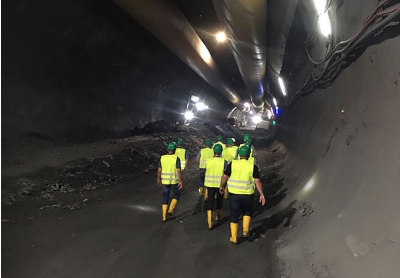
Eindrucksvoller Blick in den Brenner-Basistunnel (BBT). (Bild: HTI GIENGER KG)
