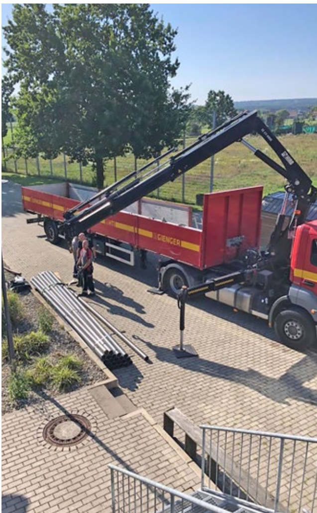
Projektbezogene Baustellenbelieferung just in time. (Bild: HTI GIENGER KG)
