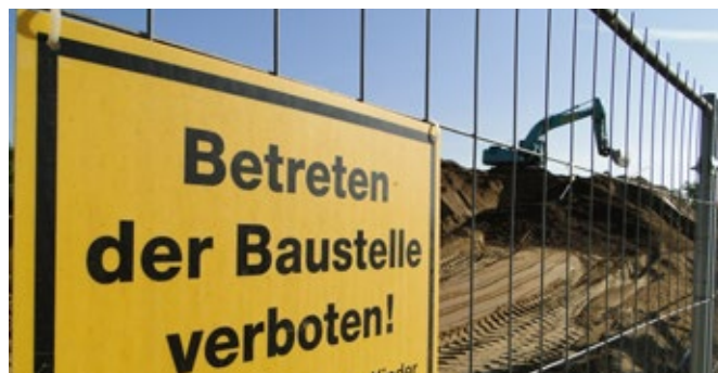
Achtung Baustelle! Die Baugrube ist sechs Meter tief. (Bild: HTI BÄR & OLLENROTH KG)
