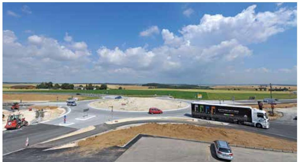
Beim großen Betonkreisel mit seinen 60 Metern Durchmesser ist neben der Betongüte vor allem die Konstruktion wichtig. Dabei sind die Zufahrtsarme vom Teller des Kreisverkehrs statisch getrennt. Quelle: HeidelbergCement/Fuchs
