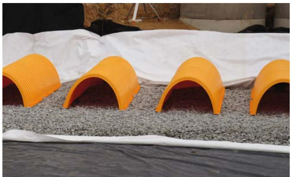
Die BIRCO-Rigolentunnel dienen der dezentralen Versickerung oder gedrosselten Einleitung. (Quelle: BIRCO)
